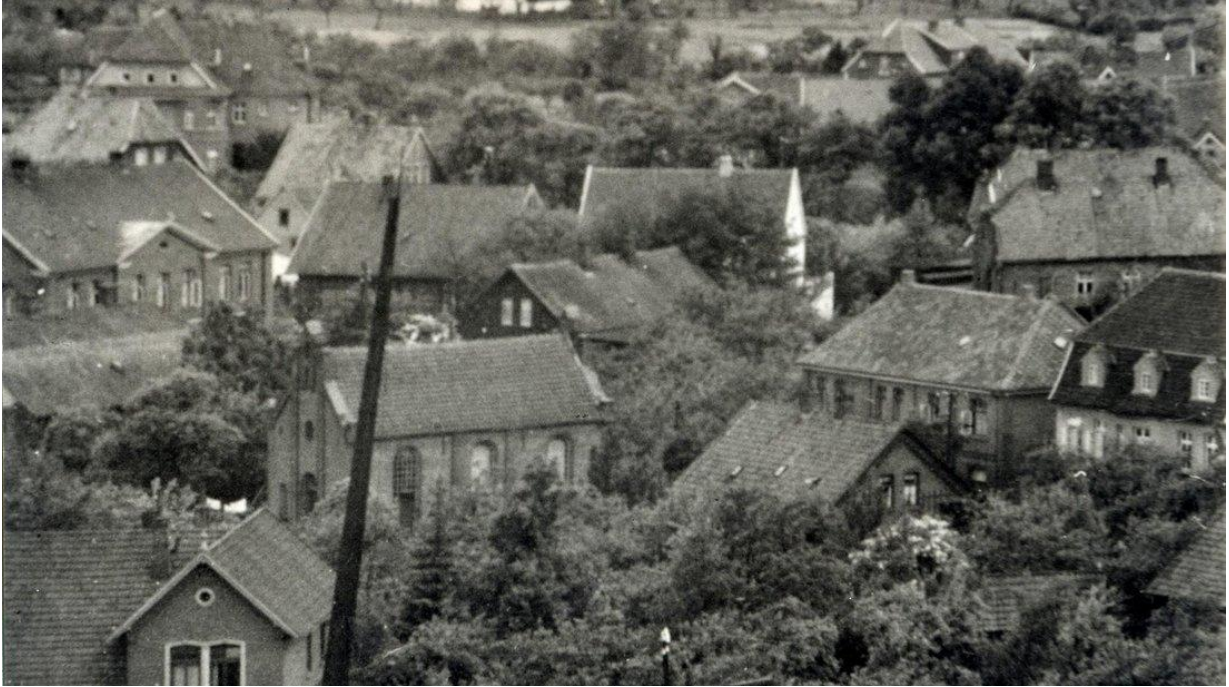
Die Lingener Synagoge wurde in der Reichspogromnacht bei einem Brand komplett zerstört - hier das einzige Bild vor der Zerstörung, aufgenommen von der Kokenmühle. Foto: Stadtarchiv Lingen
