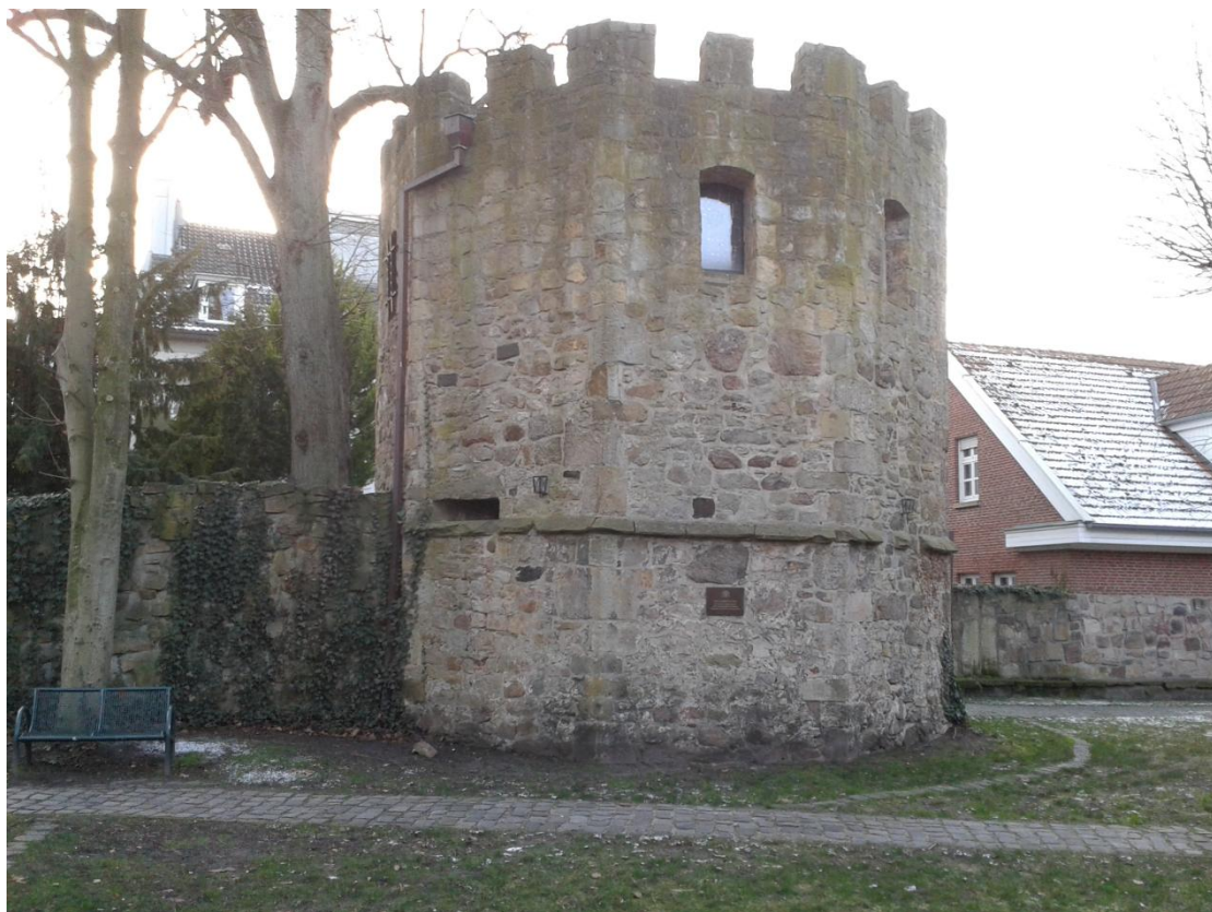
Der in den 1960er Jahren zum Teil wieder aufgebaute Pulverturm auf dem ehemaligen Burggelände in der Innenstadt von Lingen.
